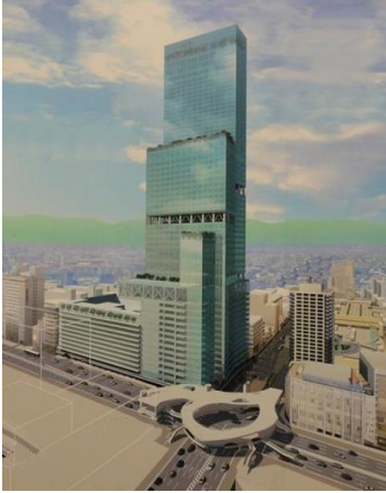
Den 300 m høje bygning i Osaka med danske friktionsdæmpere
