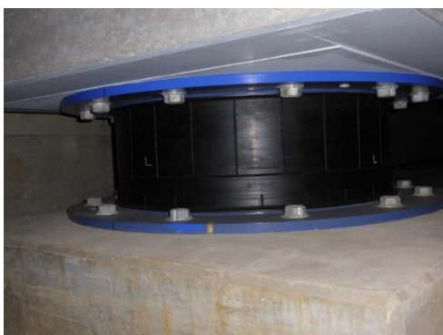
Natural rubber damper mellem fundament og søjle
